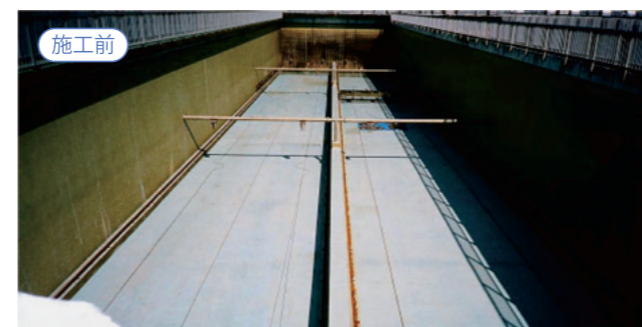
浄水場沈澱池
